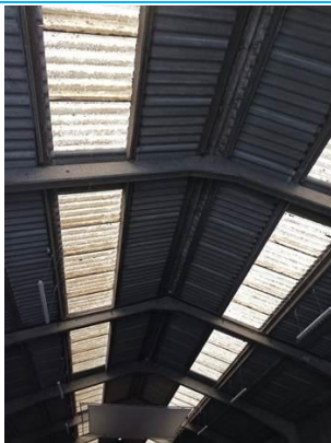
Matériaux : ZPSO-001 Prélèvement : Description : Plaques (fibres-ciment) Localisation : Extérieur - Toiture Résultat : Présence d'amiante
