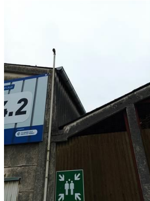
Matériaux : ZPSO-002 Prélèvement : Description : Plaques en bardage (fibres-ciment) Localisation : Extérieur - Toiture Résultat : Présence d'amiante
